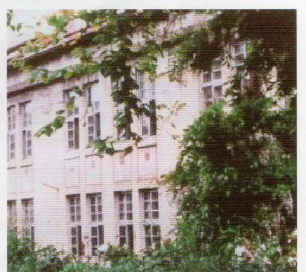
▼解体前の校舎(昭和55年6月)
